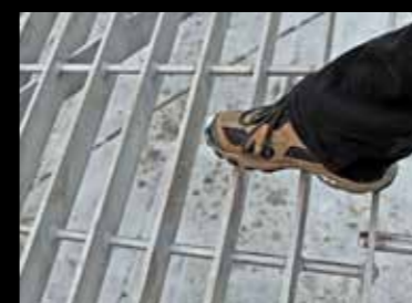
Foten med sko str. 44 viser størrelsen på glippene i den nye turbinristen.
